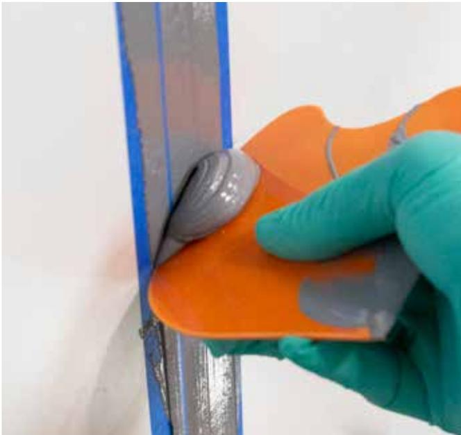
Belzona 4511 es un sellador elastomérico sin solventes de dos componentes para juntas de expansión de construcción verticales y horizontales.
