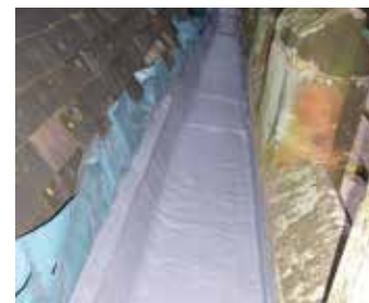
Juntas de canaletas
